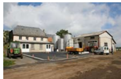
Coopérative Chamberton Ets Dischamp à Neuvéglise Modernisation atelier.
