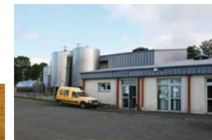
Coopérative Fromagère de la Planèze à Pierrefort
